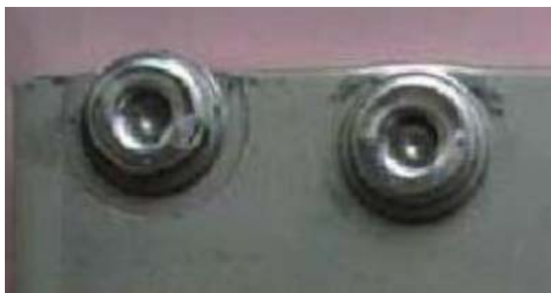
图15边缘铆扣示意图
