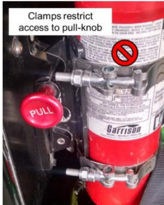
图B-46：灭火器夹头方向错误。
