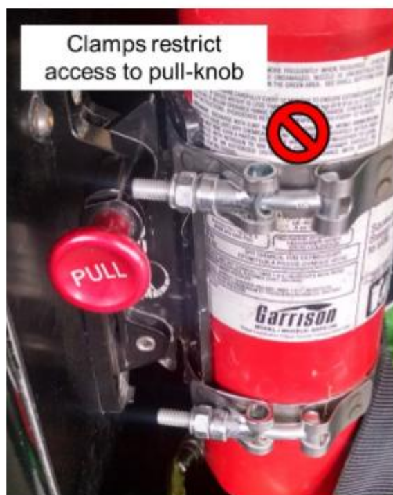
图B-55 灭火器夹头方向错误。
