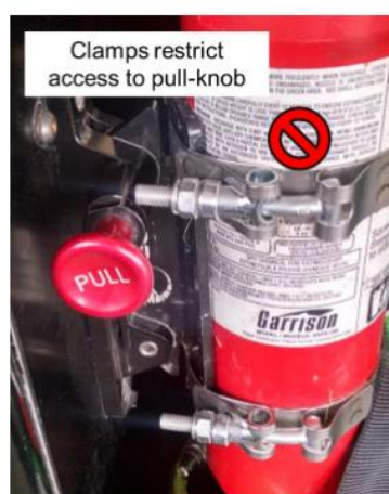
图B-56 灭火器夹头方向错误。
