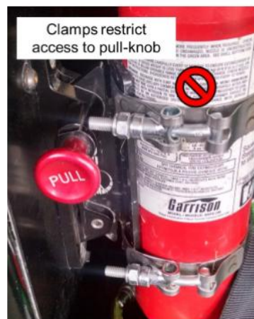
图B-57 灭火器夹头方向错误。
